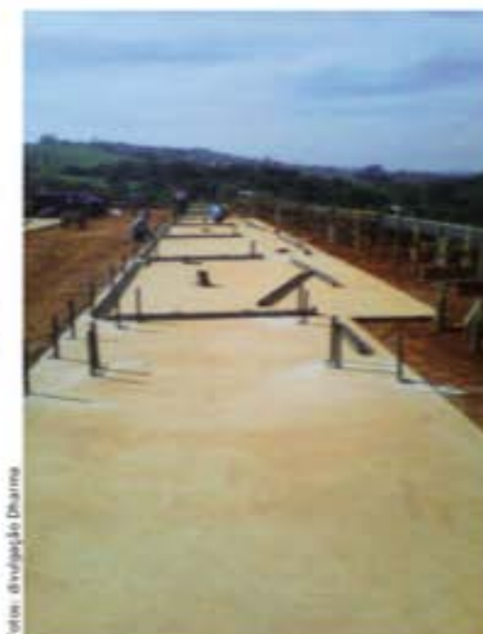
Pista de concreto
