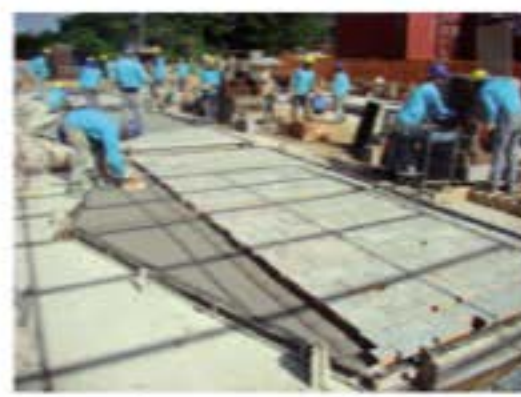
Distribuição dos blocos cerâmicos
