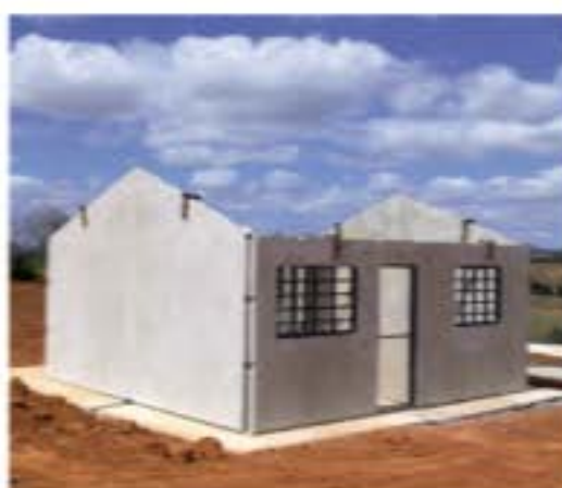
Estrutura da casa montada
