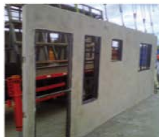
Fixação do painel sobre o radier
