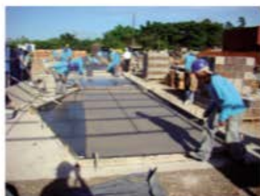
Moldagem do painel
