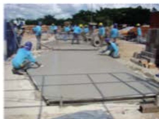
Regularização com argamassa
