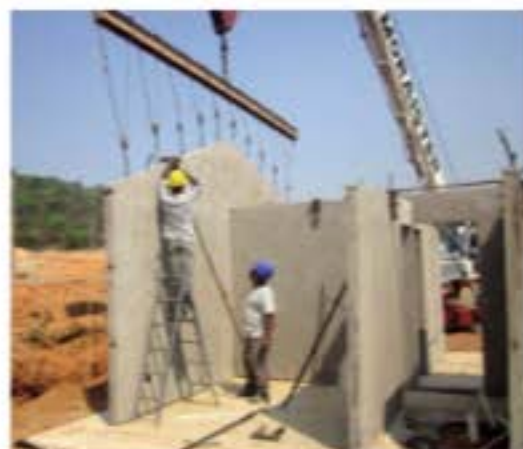
Montagem da casa
