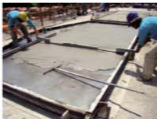
Lançamento de argamassa
