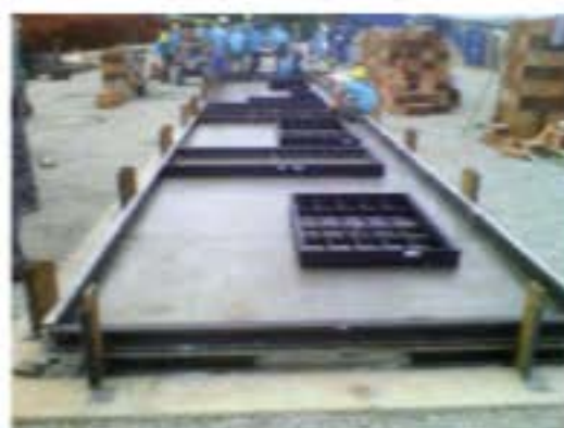
Posicionamento de porta e janelas
